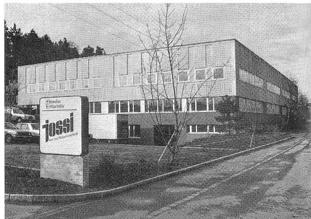
Zwischen SBB-Anschluss und alter Landstrasse im Grünen die zweckmässige und lichte Fabrikliegenschaft
