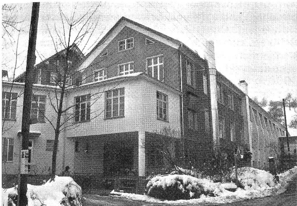
Blick auf das Betriebsgebäude
