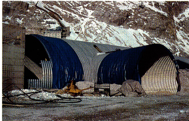
Eingangs-/Ausgangsbereich der Bahnsteighalle mit dem PVC-beschichteten Trevira® Hochfest-Gewebe, beidseitig mit Trevira® Spunbond-Geotextilien abgedeckt als Schutz gegen mechanische Beschädigung und gegen Wasser.
