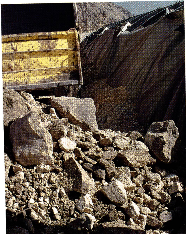
Das Geotextil der Höchst AG verhindert das Durchschlagen von kantigem und felsigem Material schadlos. Foto Höchst AG.
