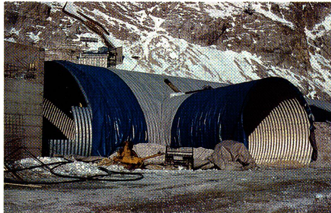
Eingangsbereich der Bahnsteighalle mit dem PVC-beschichteten Trevira® Hochfest-Gewebe, beidseitig mit Trevira® Spunbond-Geotextilien abgedeckt als Schutz gegen mechanische Beschädigung und gegen Wasser.
