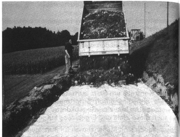
Geotextilien im Strassenbau. Nadelvlies. 1986 sollen weltweit über 400 Millionen Quadratmeter verschiedenartigster textiler Flächen gebildet im Bauwesen eingesetzt worden sein.
