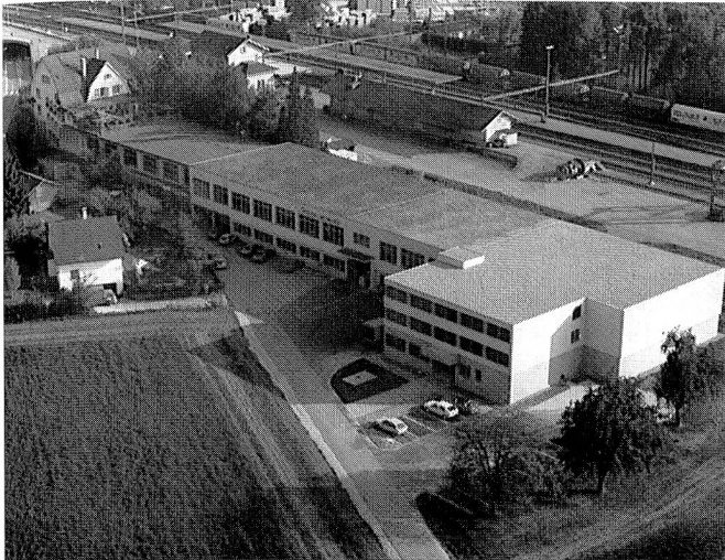
Rechts im Vordergrund der langgestreckten Fabrikliegenschaft der vor kurzem bezogene Neubau
