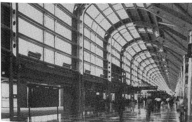
Lüftungs- und Klimaanlage sowie die Feuersicherung im Flughafen Chicago werden von einem Gebäudemanagement-System von Landis & Gyr Powers, Inc. geregelt und überwacht.
