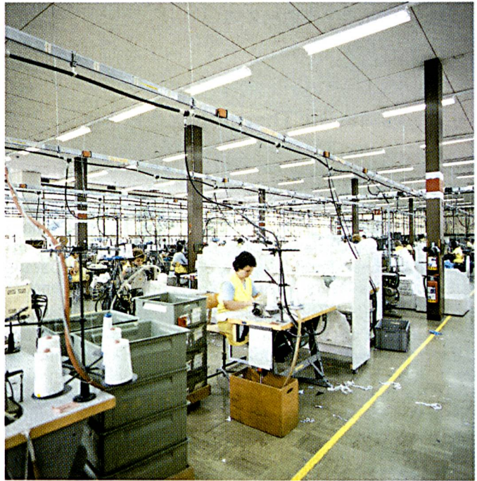
Moderne, mit Reflektoren ausgestattete Lichtleisten an Montageschienen bieten in der Näherei der SIDEMA SA, Lugano, einen zeitgemässen Beleuchtungskomfort. Gleichzeitig reduzieren sie den Energieverbrauch der Beleuchtungsanlage auf weniger als die Hälfte des bisherigen Wertes. (Foto Zumtobel AG)
