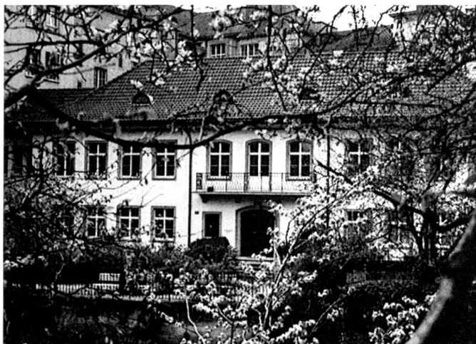
Am Hauptsitz der Desco von Schulthess AG, an der Brandschenkestrasse in Zürich, laufen die Fäden der weltweiten Aktivitäten zusammen.
