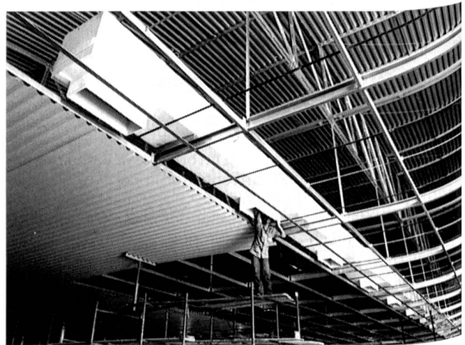
Montage von Deckenkanälen für eine Weberei im pazifischen Raum
