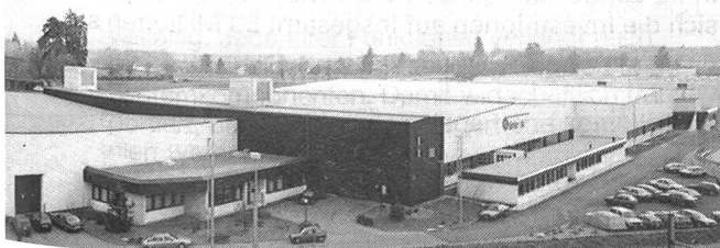
Gesamtansicht der Filinter SA, Genf
