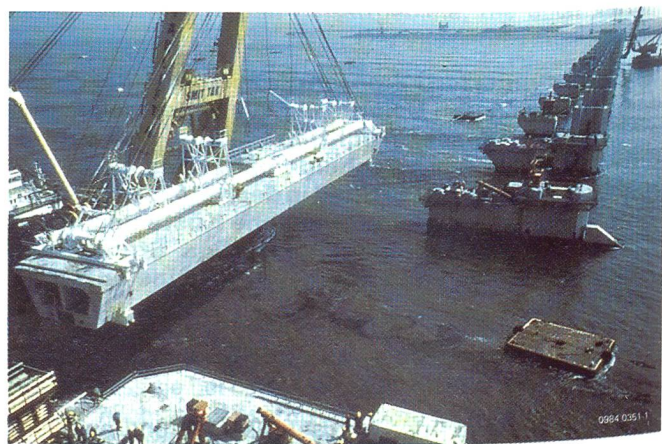
Bild 3 Die bewegliche Sturmflutbarriere in der Oosterschelde, letztes und aufwendigstes Glied in der Kette der Wasserbauwerke, die die niederländische Küste und damit Millionen Menschen gegen künftige Sturmfluten schützen.
