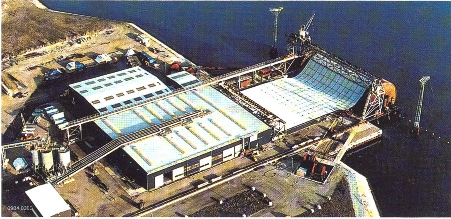
Bild 9 Produktionsstätte auf der Arbeitsinsel Neeltje Jans, wo die Filtermatratzen in einem kontinuierlich ablaufenden, vollautomatisierten Arbeitsprozess hergestellt wurden.
