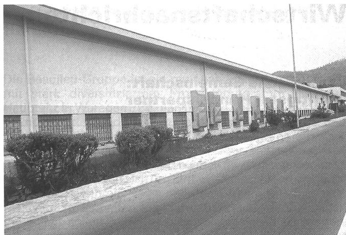
Die bereits renovierte Fassade des Webereigebäudes
