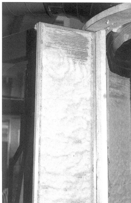
Abb. 4: Mit dem BEN-VAC abgesaugte Staubmenge
