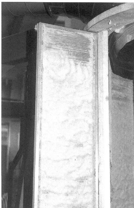
Abb. 4: Mit dem BEN-VAC abgesaugte Staubmenge
