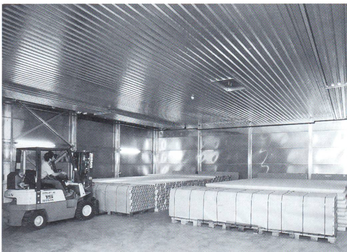
Bild 1: Die Trockenkammer Fotos: Hülsenfabrik Lenzhard
