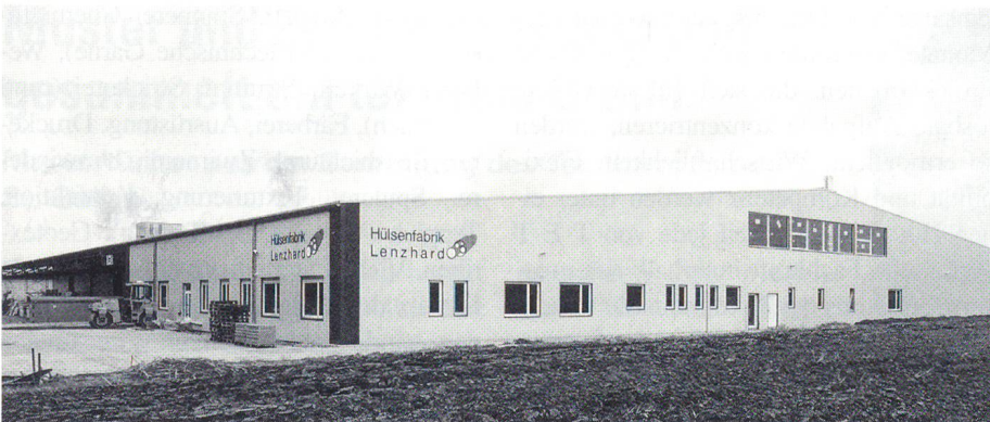
Neubau der Hülsenfabrik Lenzhard
