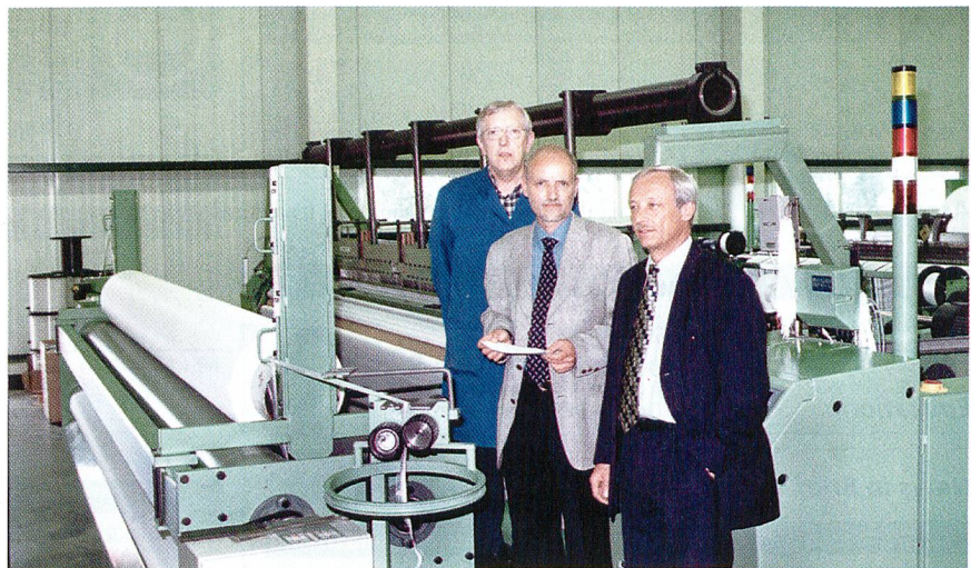
Die Herren Werner Kandel (Mitte), Technischer Direktor, und Erich Wenke (links), Webereileiter, der Firma Cramer und Ulrich Isler (rechts), Regionalverkaufsleiter, von Sulzer Textil vor einer bereits installierten Projekttilwebmaschine aus dem Bereich "Customized Weaving Technology" mit einer Arbeitsbreite von 540 cm
