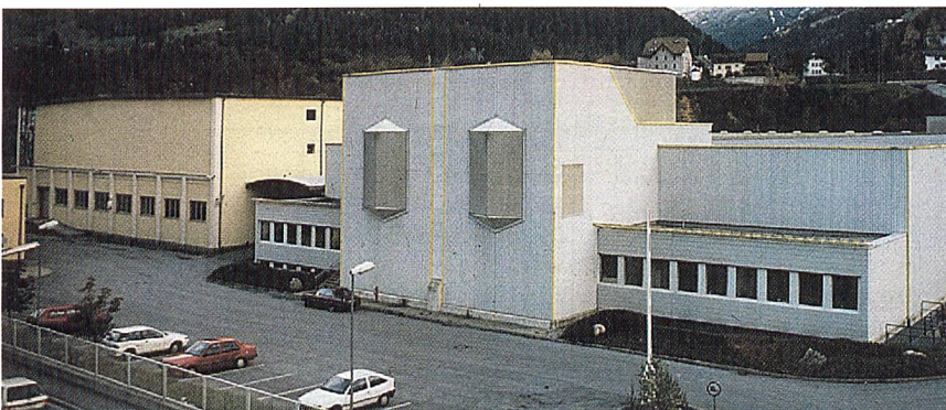
Gesamtansicht der Spinnerei Landeck
