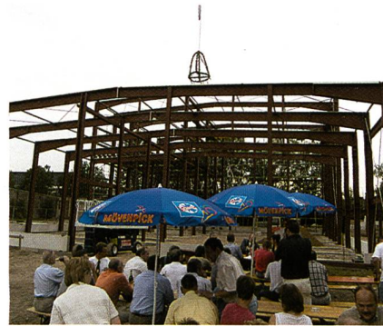
Aufrichtung der neuen Anlage
