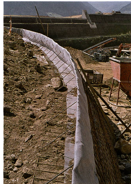
Abb. 3: Bepflanzbares System aus Vliesstoff für Steilböschungen
