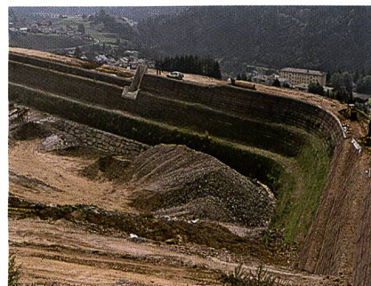
Abb. 2: Der neue Schutzdamm im Bau
