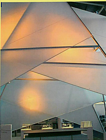
Membranbau – HF – Schweissen
