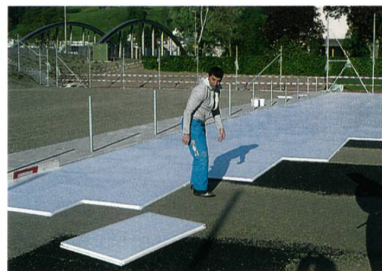
Verlegen der Unterlagsplatten
