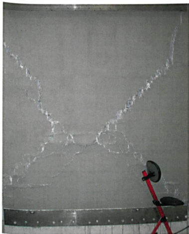
Mauersegment nach dem Erdbeben-Test
