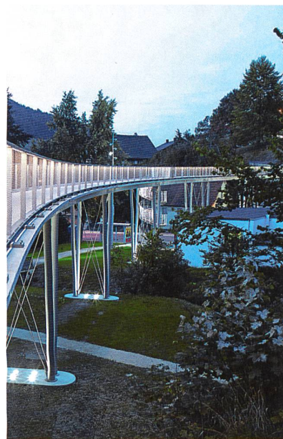
Abb. 1: Die längste Textilbetonbrücke der Welt
