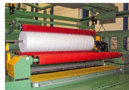
Abb. 3: Die Bastian Wicklertechnologie wurde bei Truetzschler Nonwovens integriert
