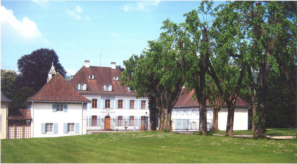
Abb. 1: Blick von Südwesten auf Schloss Ebenrain, rechts der Beginn der barocken Lindenallee.
