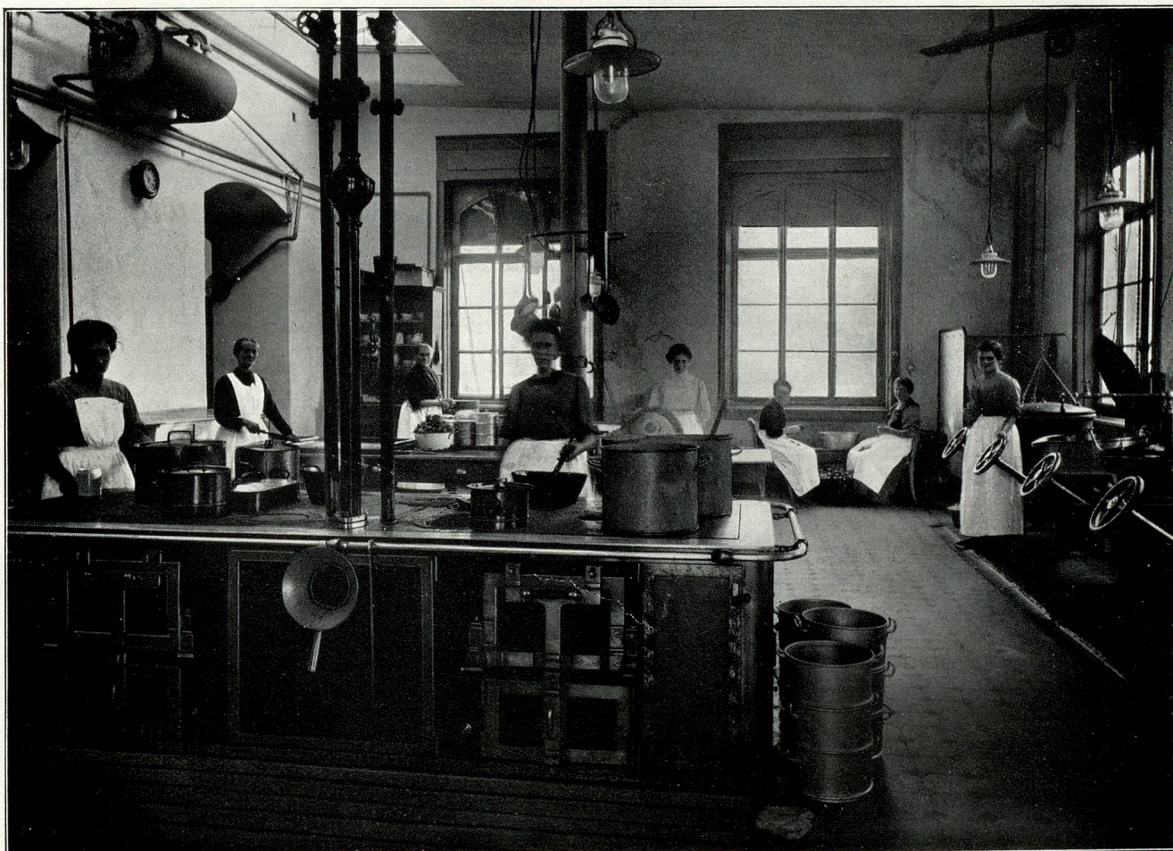
Die Küche im Kantonsspital Münsterlingen
