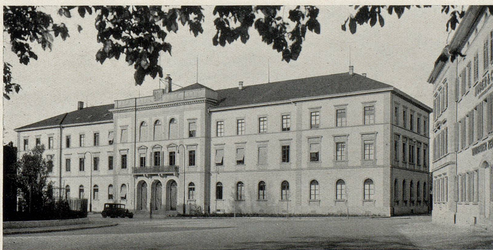
Das Regierungsgebäude nach der Renovation.
