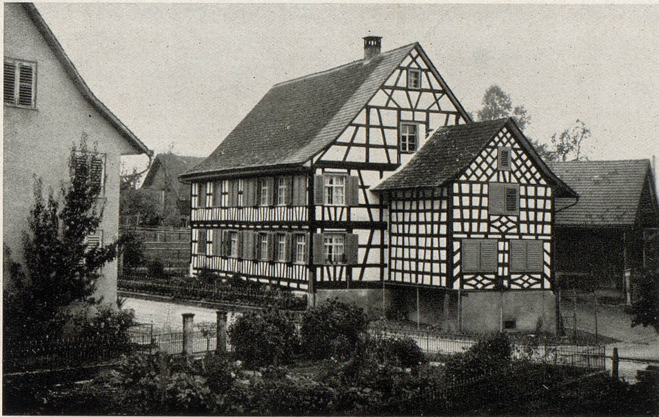
Das Rüegger'sche Anwesen in Schönholzerswilien.
