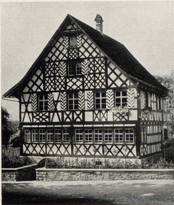
Das alte Gerichtshaus in Landschlacht.
