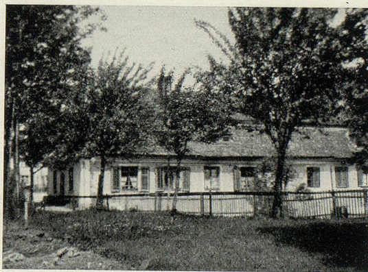
Das jetzige Herrschaftshaus in Griessenberg. (Ende des 18. Jahrhunderts erbaut). Nach Photographie.
