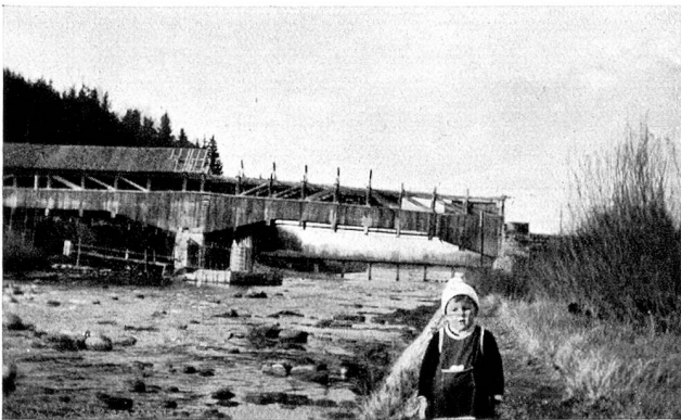
Der Abbruch hat begonnen
