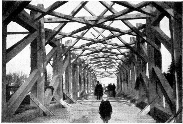
Das kunstvolle Balkengerüst der alten Brücke
