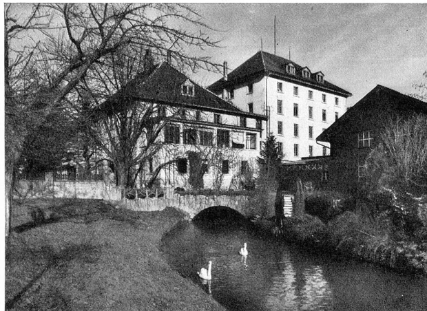
Ansicht von Süden: Bureau- und altes Fabrikgebäude, Kantine
