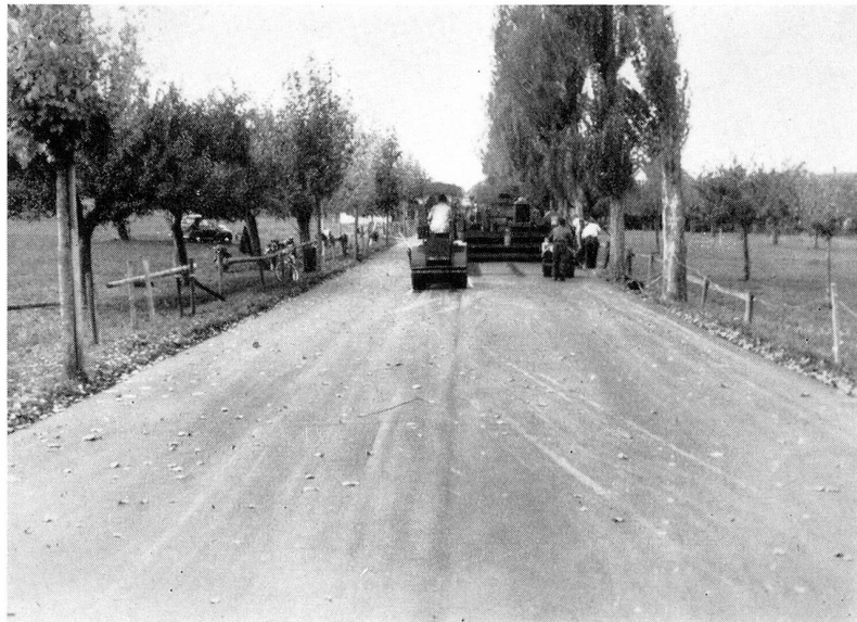
Einbau Teppichbelag Erlen mit Straßenfertiger
