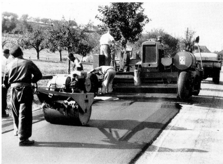
Einbau Teppichbelag Erlen mit Straßenfertiger
