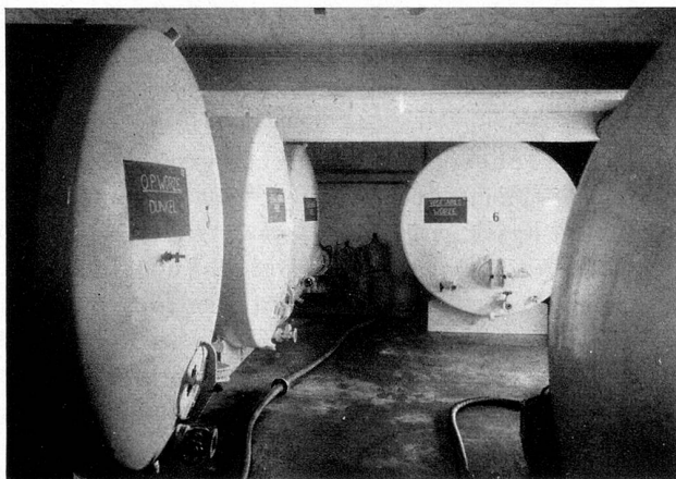
Sechs Großtanks zur Lagerung von etwa 12 000 Kilo flüssiger Würze
