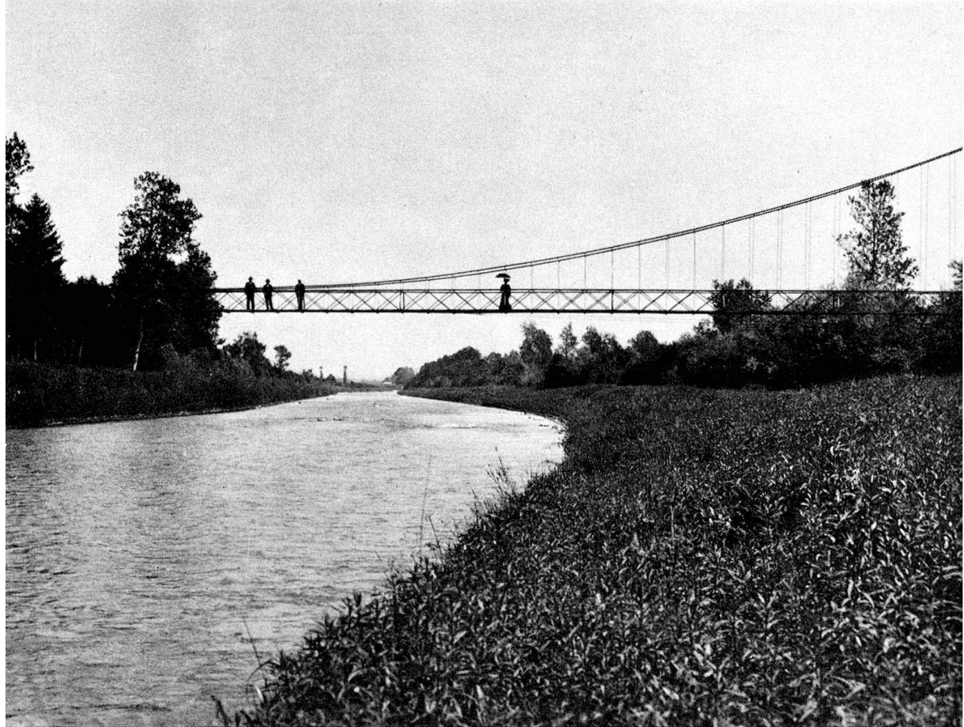
Der Gangelstieg bei Weinfeldern.
