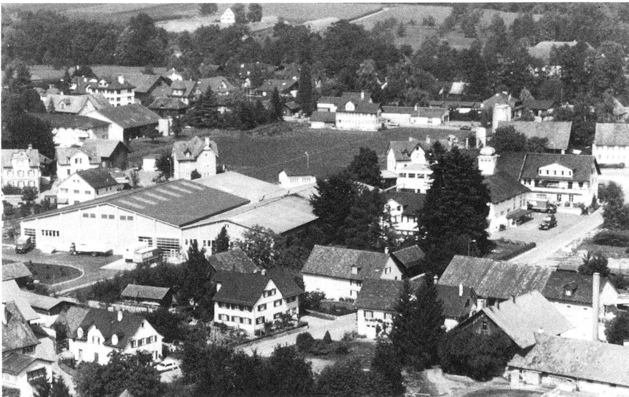
Mosterei Möhl: Firmenareal in Stachen bei Arbon.
