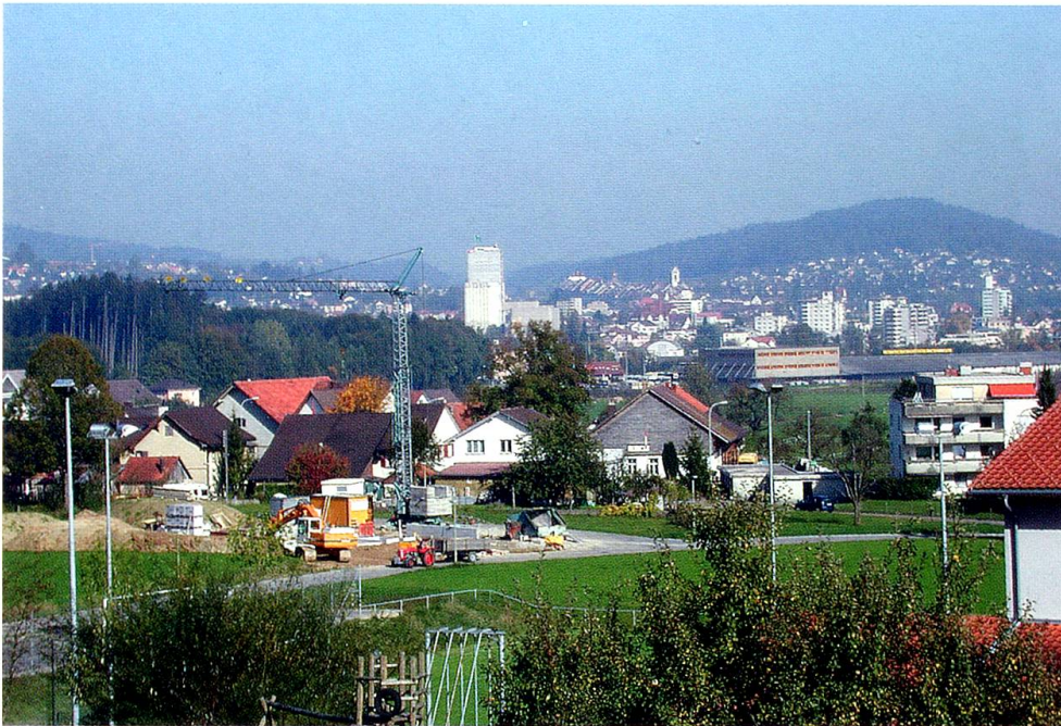
In Busswil vermarktet die Gemeinde ihr eigenes Bauland. Hier entsteht ein attraktives Einfamilienhausquartier direkt vor den Toren der Stadt Wil.
