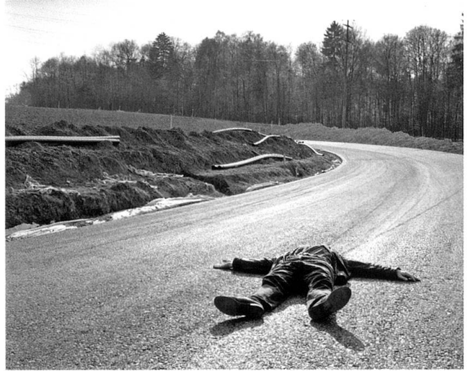
Bau der N7, 20.3.1991
