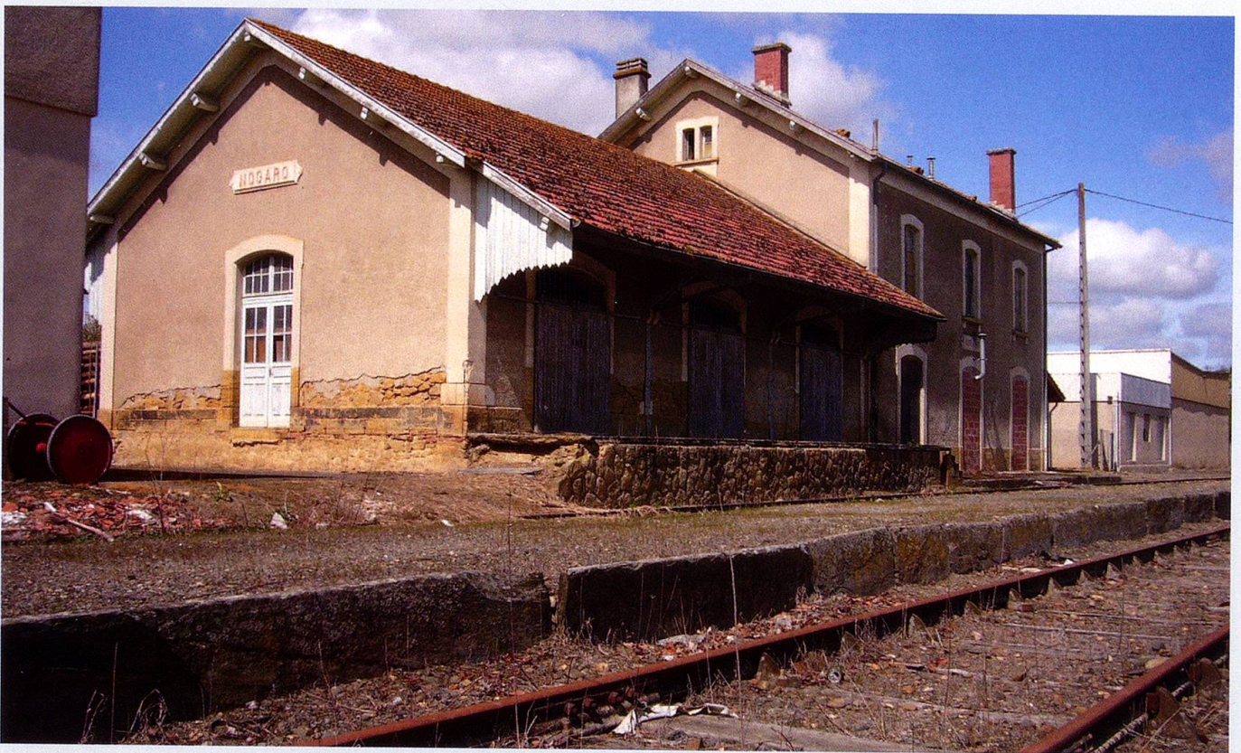
Der Bahnhof Nogaro an der jetzt geschlossenen Bahnlinie.
