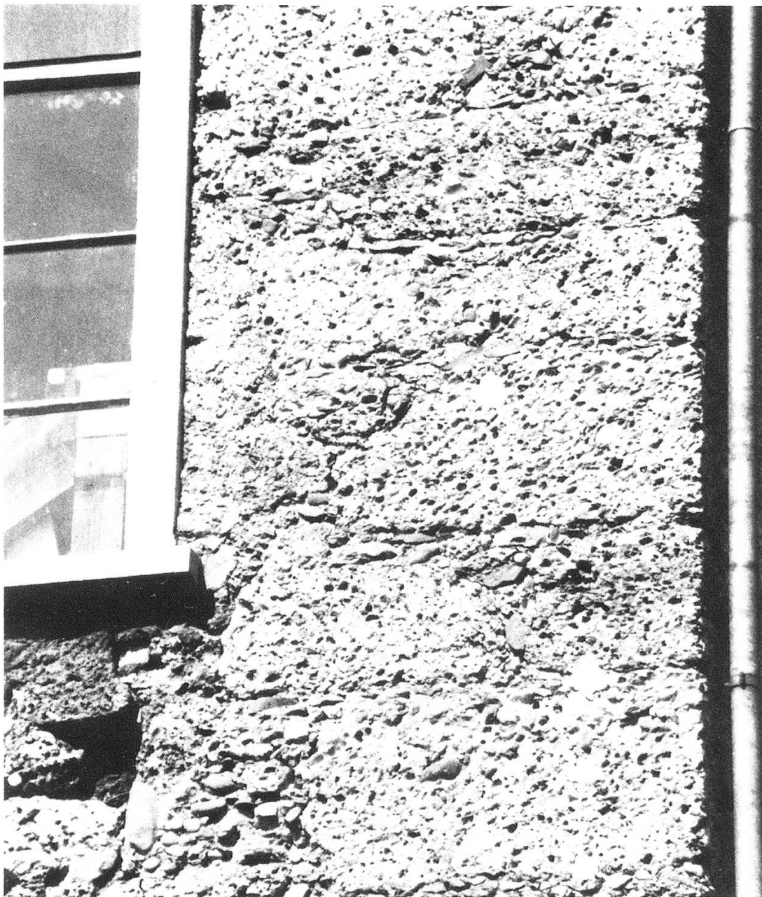
Abb. 16: Gebäude (Ausschnitt aus Westwand) der Papierfabrik Bischofszell: Als Baustein wurde der Felsenholzschotter verwendet.
