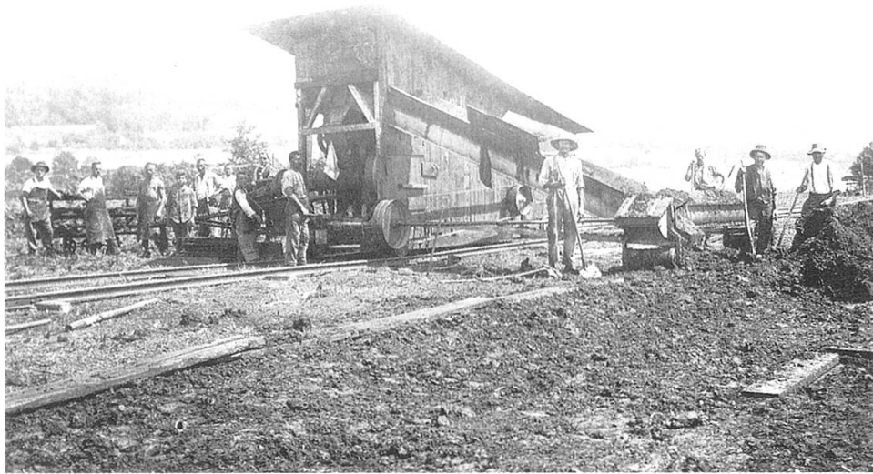
Abbildung 1: Im Bürgerried wurde um 1920 Torf maschinell gepresst.
