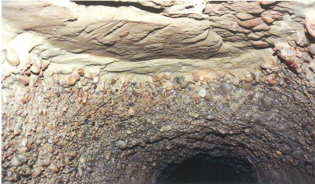
Abbildung 11: Fassungsstollen Schocherswil: Ein Schotterkörper von innen!
