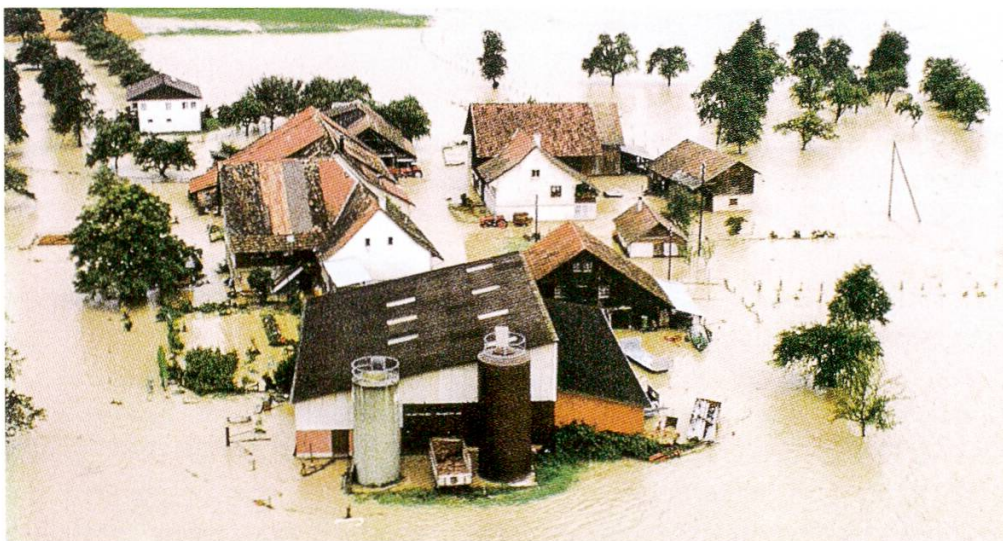
Abbildung 5: Hochwasser August 1978; Thurtal unter Wasser, Lokalität Wyden, Uesslingen (Foto: Kantonspolizei TG).
