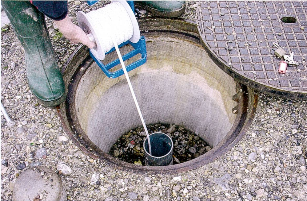
Abbildung 6: Grundwasserspiegelmessung mit dem Kabellichtlot. Die Referenzhöhe muss klar festgelegt sein.
