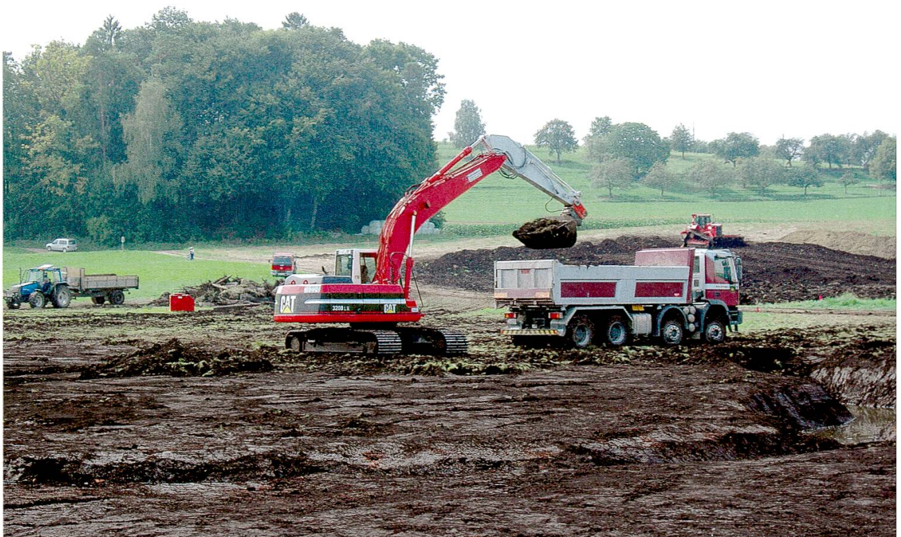
Abbildung 6: Renaturierungsarbeiten westlich des Hasensees. (Foto: Joggi Rieder)
