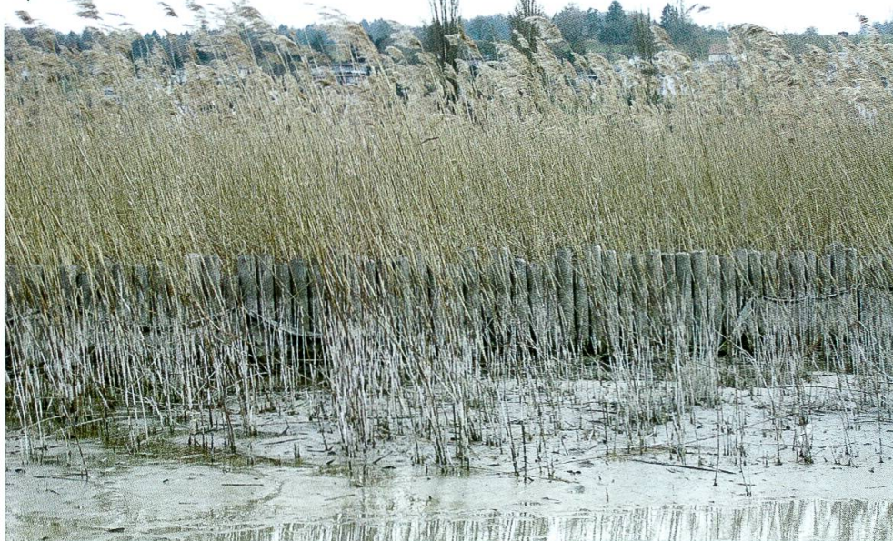
Abbildung 15: (a) Wellenbrecher (Schwimmkampen und Palisaden) im Schilfgebiet vor Triboltingen mit Beobachtungsplattform (Nov. 1985); (b) ehemalige Schilfschutz-Palisaden vor Triboltingen (10.03.2011, beide Fotos: W. Ostendorf).
