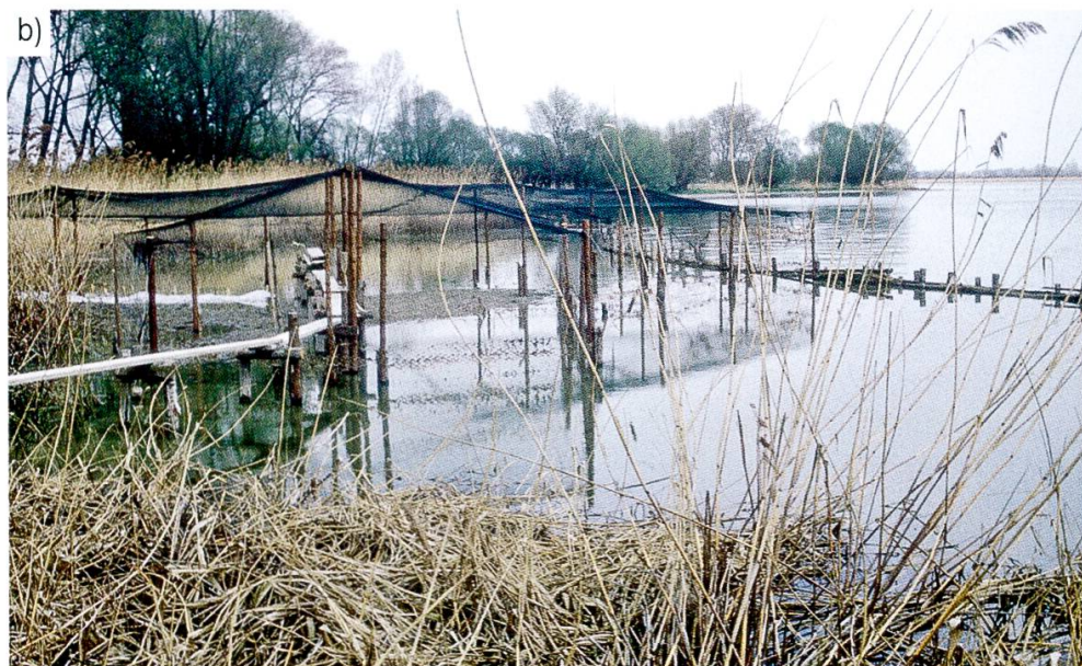
Abbildung 16: (a) Vorbereitung einer Schilfpflanzung: ausgegrabene Rhizome werden sortiert, um später in die Pflanzfläche eingebracht zu werden; (b) Schilfpflanzversuch des Instituts für Seenforschung am Südufer der Insel Reichenau (Schopflen, Bruckgraben): die eingebrachten Stecklinge werden mit Palisaden und Netzen vor Treibgut und Vogelfrass geschützt (Mai 1987, beide Fotos: W. Ostendorf).
