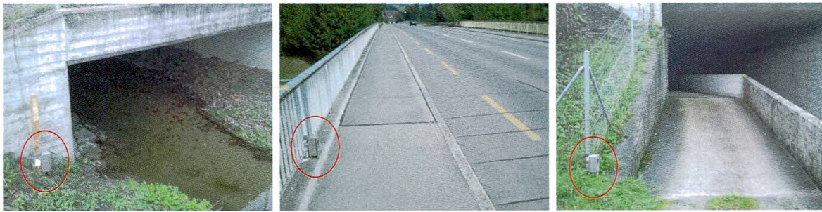
Abbildung 7: Beispiele für die Installation der Fotofallen an einem Gewässerdurchlass, einer Überführung und einer Unterführung.
