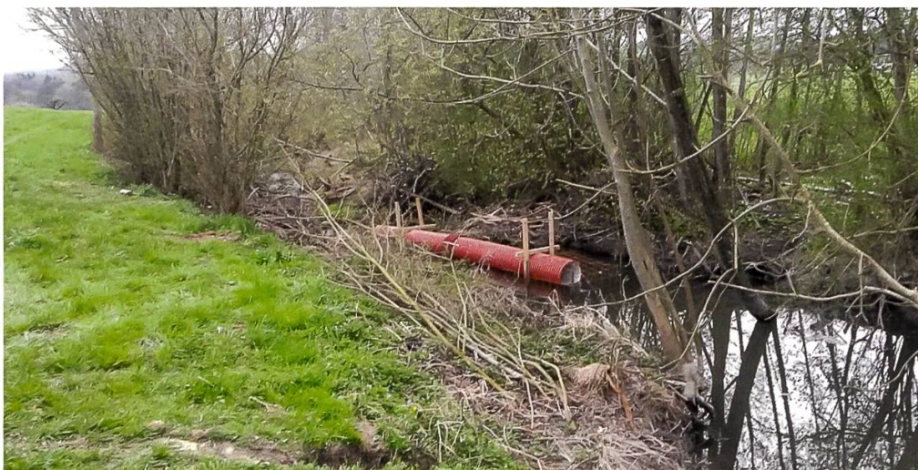
Abbildung 5: Am Furtibach in der Gemeinde Kemmental lebt seit 2006 eine Biberfamilie. Wegen den von ihr erstellten Dämmen trat der Bach über die Ufer und landwirtschaftliche Drainagen wurden eingestaut. Durch den Einbau zweier Dammdrainagen konnte der Wasserstand gesenkt und das Problem entschärft werden. Der Unterhalt der Einrichtung wird von der Gemeinde übernommen. Foto: Michael Vogel, Jagd- und Fischereiverwaltung des Kantons Thurgau.
