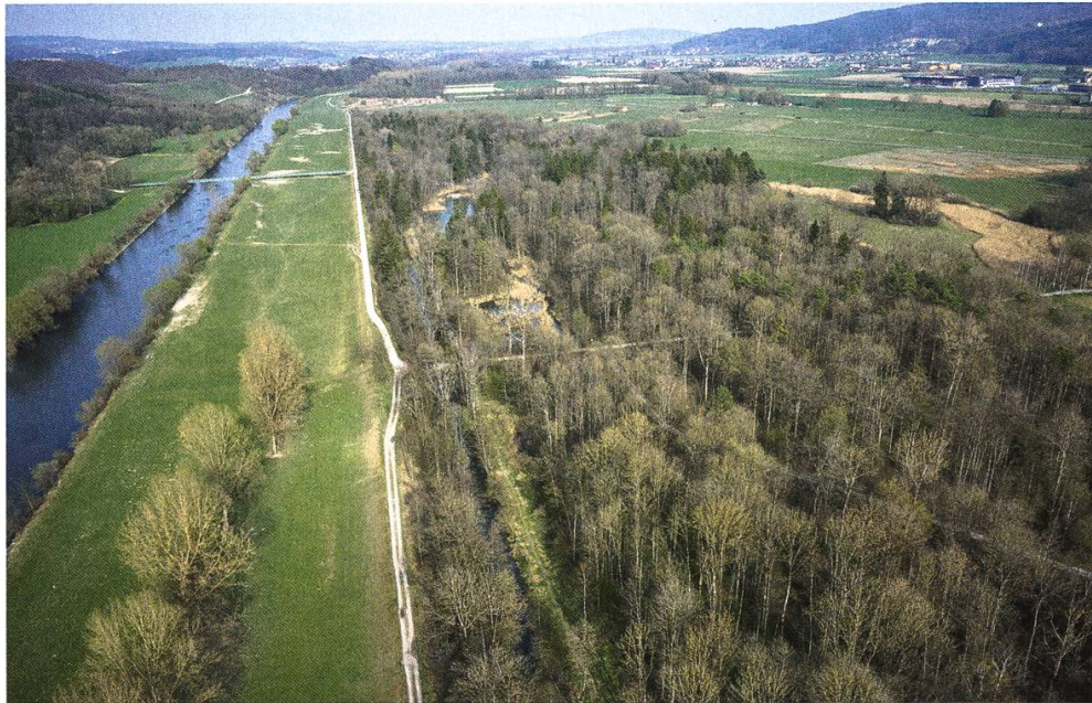
Abbildung 3: Thurlauf und Allmend, Blickrichtung flussaufwärts. Links ist die begradigte Thur und das Vorland, teilweise mit Sandablagerungen und Pappeln, sowie der Ochsenfurtsteg zu erkennen. Der Hochwasserdamm trennt den alten Auenwald von der Thur ab. Hinter dem Damm verläuft der Binnenkanal mit Altläufen. Im Hintergrund ist ein Teil der «naturnahen, aufgewerteten» und der landwirtschaftlich genutzten Allmend zu erkennen. Foto: Donald Kaden, 31.03.2014.
